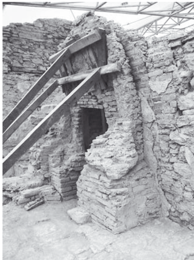
Abb. 159: 38h, Praefurnium in der S-Mauer
