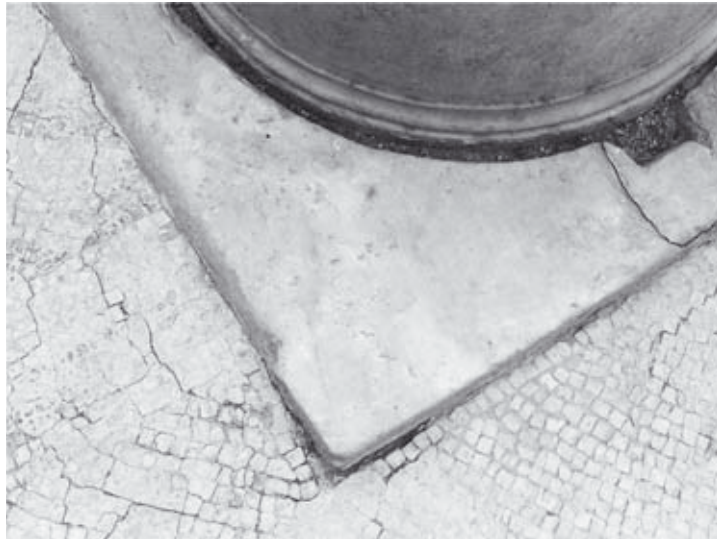
Abb. 112: 38b, N-Umgang, an die Einfassung des Tiefbrunnens angesetztter Mosaikboden
