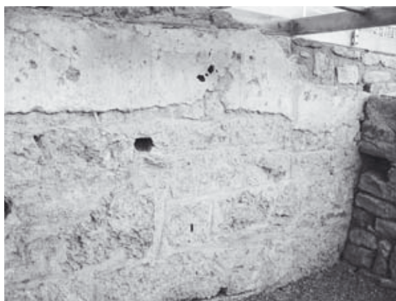
Abb. 80: 38aS, westlicher Teil der S-Mauer
