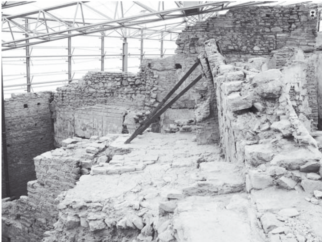
Abb. 152: 38h, Ansicht von Westen
