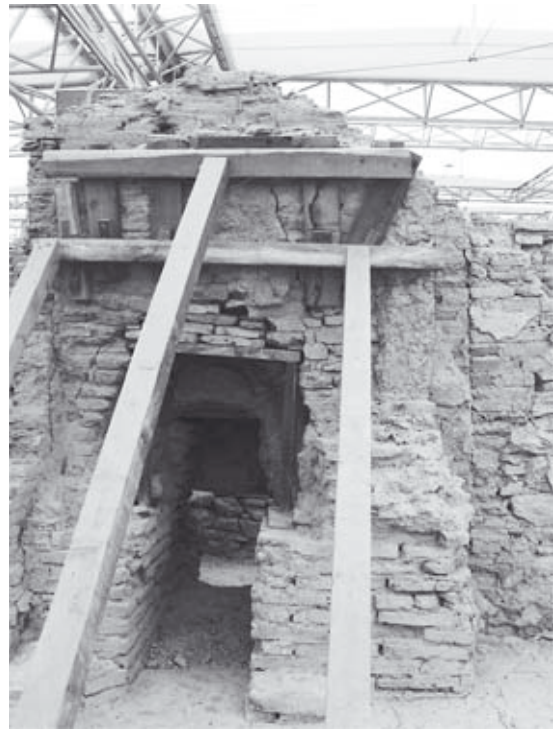
Abb. 158: 38h, Praefurnium in der S-Mauer
