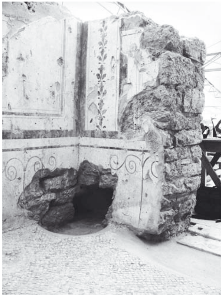
Abb. 79: 38a, NW-Ecke mit Abflussöffnung
