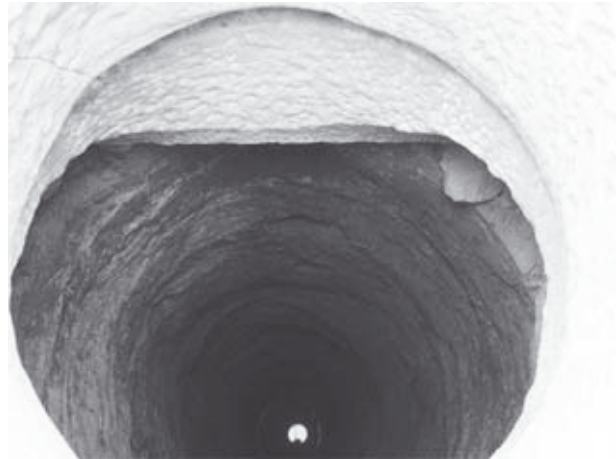
Abb. 64: 38, Blick in den Brunnenschacht
