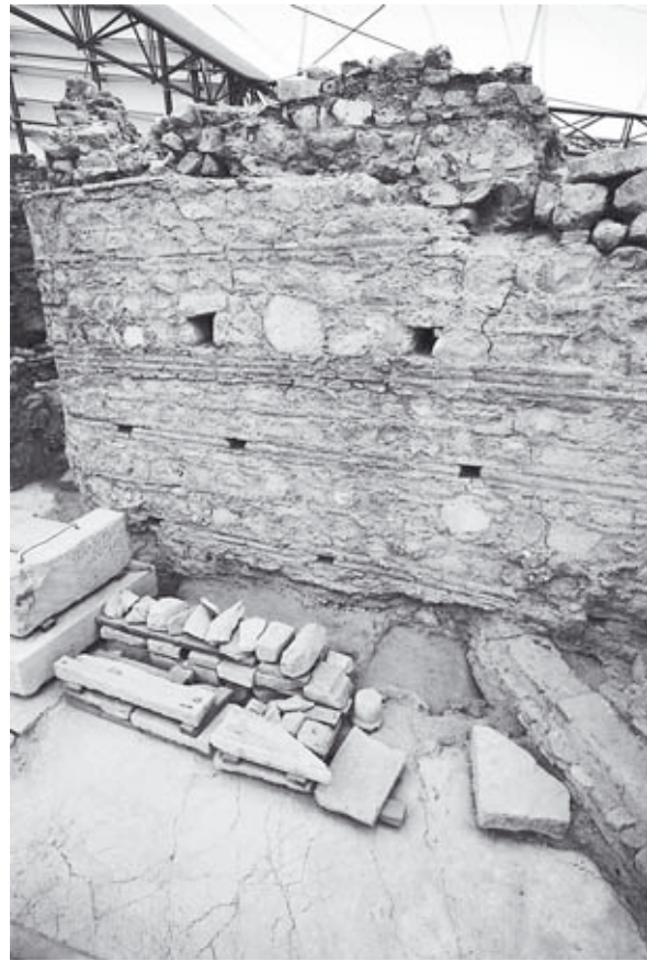
Abb. 99: 38b, Nordwest, spätantik-frühbyzantinische Mauer
