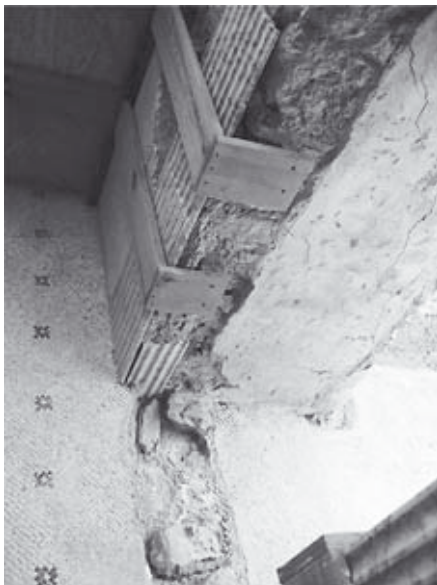
Abb. 122: Türöffnung zwischen 38c und 32e
