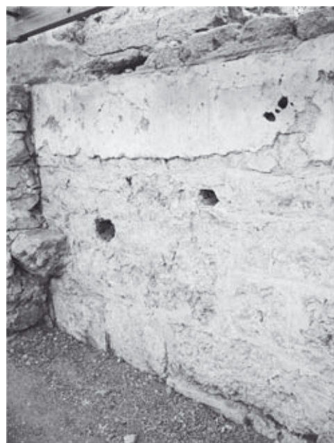
Abb. 81: 38aS, östlicher Teil der S-Mauer
