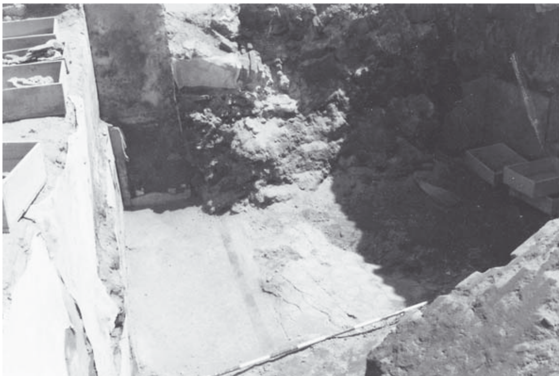
Abb. 128: 38d, Freilegung des östlichen Bereichs
