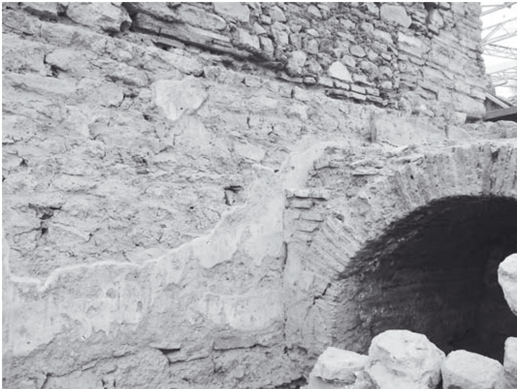
Abb. 150: 38g, O-Mauer mit Wandmalerei, die sich an 38i O-Mauer fortsetzt und an die das Gewölbe von 38g angesetzt ist
