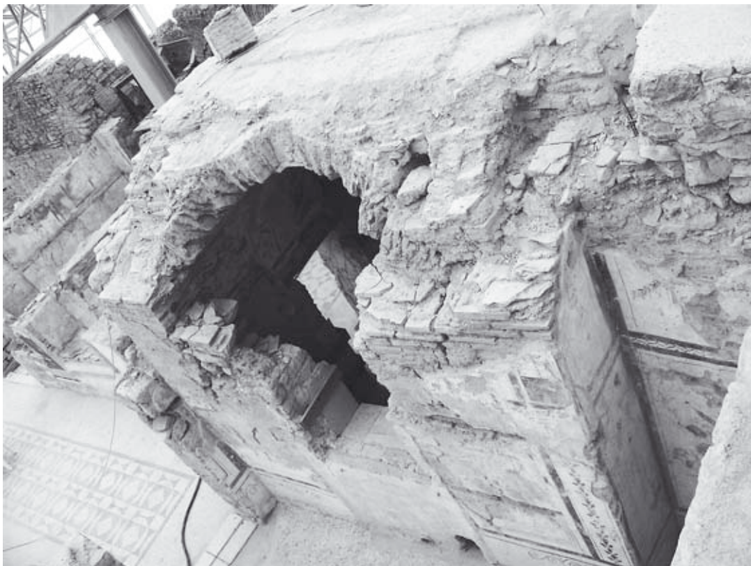
Abb. 120: Das Gewölbe von 38c, Ansicht von Westen
