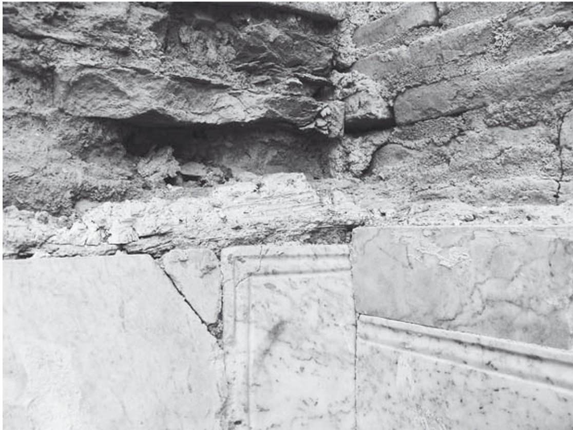
Abb. 134: 38d, Nische an der S-Mauer der Bauphase IV, SO-Ecke mit Marmorverkleidung und Stuckgesims
