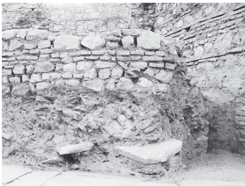
Abb. 103: 38b, W-Umgang, auf Zerstörungsschutt errichtete spätantike Mauer, Detail
